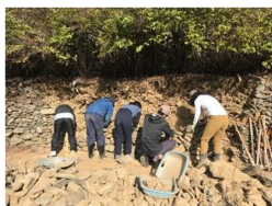
石積修復作業
