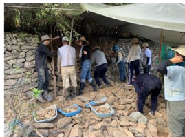
石積修復作業
